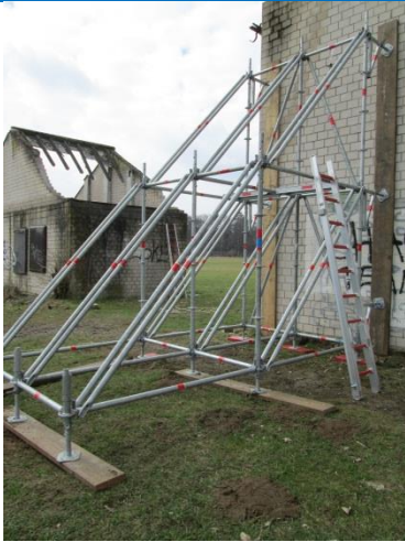
Abb.: Abstützen einer Hauswand
